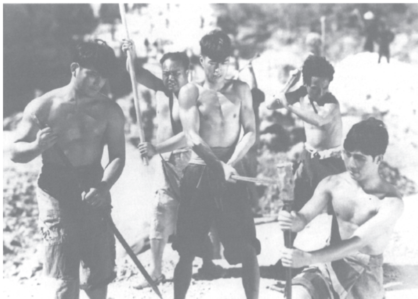
Arbetare förflyttar berg i "Den stora vägen" (1935)
